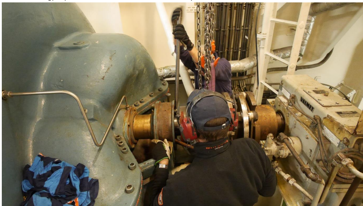
Här jobbar reparatör Pär-Åke och Förstemaskinist Johan med att dra lagret i läge.
